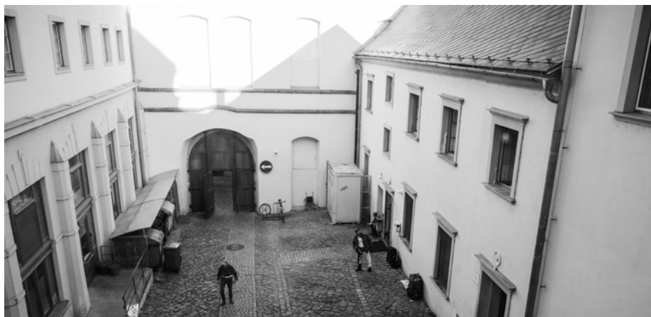
Budova na ulici Wurmova 5 po rekonstrukci. Foto: Vojtěch Cimpl.
