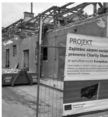
Řepčín, sundávání střešní krytiny. Zdroj: archiv CHOL.
