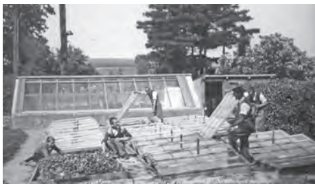
Zahrada útulku v Tršicích, ZAO, fond Arcidiecézní Charita, zásobník II., obr. č. 61
